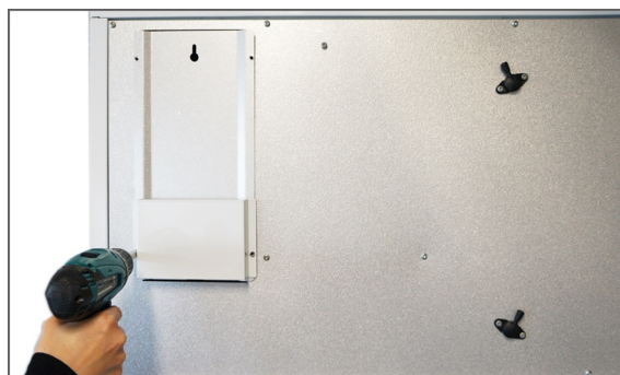
8. Fixez la plaque d'obstruction devant la carte. Remontez et fixez la trappe à l'aide des deux vis supérieures afin d'obtenir une belle surface blanche.
